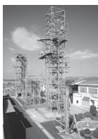
屋外試験鉄塔群
