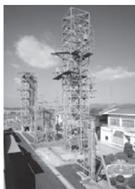
屋外試験鉄塔群
