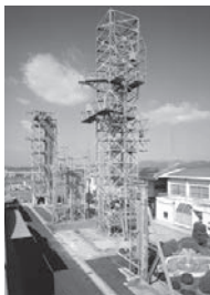
屋外試験鉄塔群
